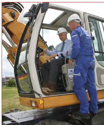
Ministerpräsident Stanislaw Tillich nahm bei Magnetto in Treuen den ersten Baggeraushub für die Halle vor, in der künftig eine neue, hochleistungsfähige Transferpresse arbeiten wird.
